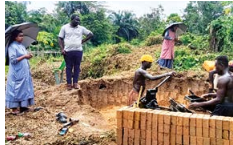
Der zuletzt ungewöhnlich lange und starke Monsun verzögert die Arbeiten.
